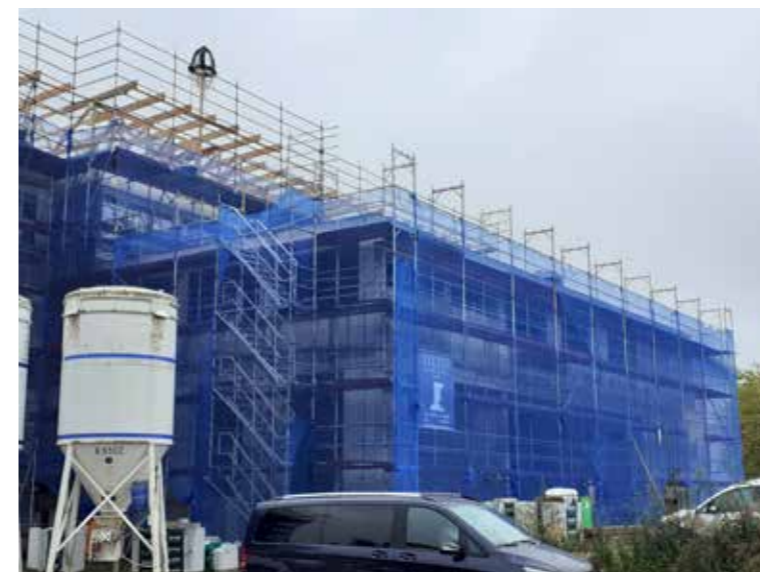
Richtfest der 2. Oberschule in Kamenz
