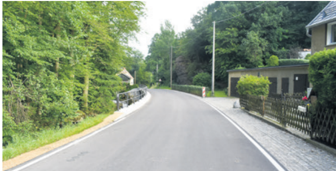
Ortslage Lauske aus Fahrtrichtung Zschorna - links Stützwand Kotitzer Wasser
