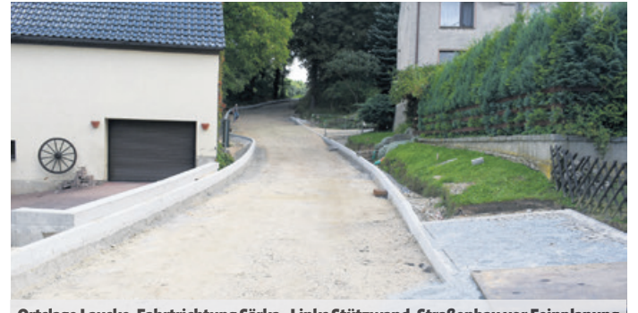
Ortslage Lauske, Fahrtrichtung Särka - Links Stützwand, Straßenbau vor Feinplanung Frostschuttschicht
