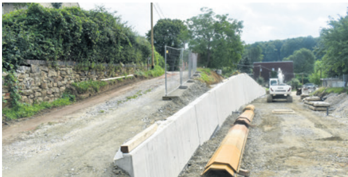
Ortslage Lauske, Ortsmitte - Im Rohbau fertiggestelltes Stützbauwerk 2
