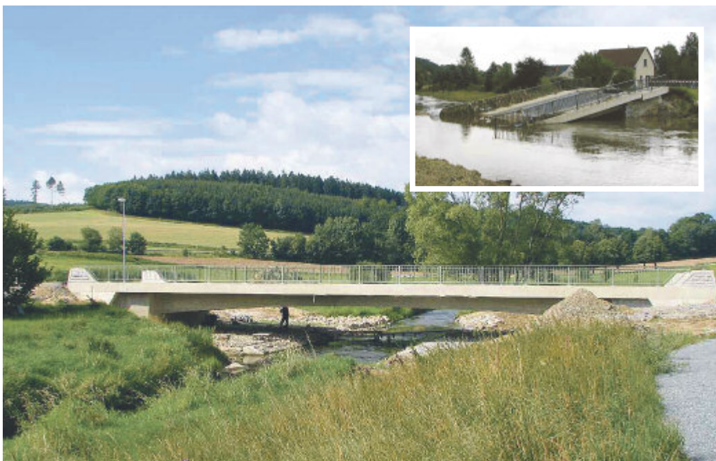
Am 24. Oktober wurde die wieder errichtete Spreebrücke zwischen Sohland und Taubenheim für den Verkehr freigegeben. Sie war im August 2010 durch das Hochwasser im Landkreis komplett zerstört worden (kleines Foto).
