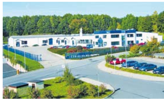
Die Werkshallen der Heuer Metallwaren GmbH in Großröhrsdorf
